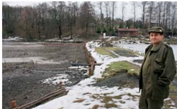
Oldřich Čablík na hrázi chovných rybníků, kterým se říká Balatony. Než je znovu napustí, je třeba je odbahnit, navápnovat, opravit hráze. Práce mají rybáři v zimním období opravdu hodně.
