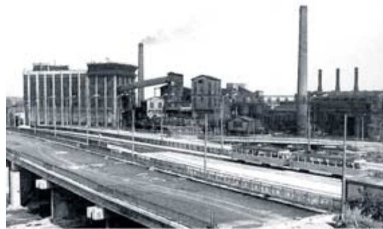
Komplex Karolina v roce 1982, v době výstavby Frýdlantských mostů.
